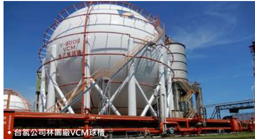
◀ 台氯公司林園廠 VCM 球槽
