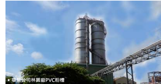
◀ 華聚公司林園廠 PVC 粉槽
