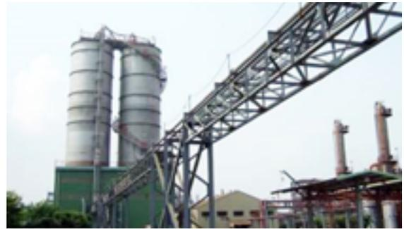
改善 PVC 粉體輸送系統及管線，降低 PVC 粉體輸送所需風量 / 風壓，減少單位產品輸送耗電量。
