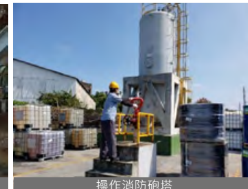
操作消防砲塔
