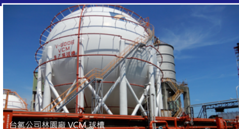
台氯公司林園廠 VCM 球槽
