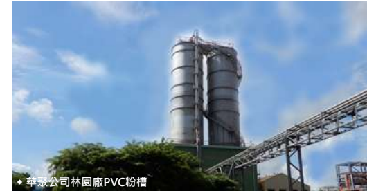
◀ 華聚公司林園廠 PVC 粉槽
