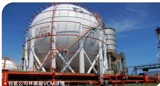
◆ 台氣公司林園廠VCM球槽
