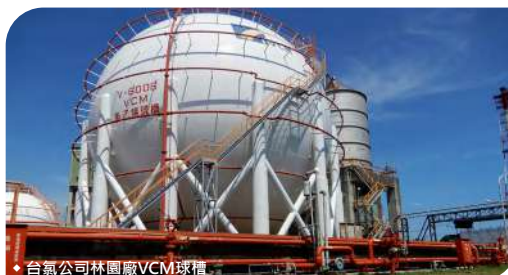
◆ 台氯公司林園廠VCM球槽
