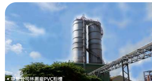
◆ 華聚公司林園廠PVC粉槽
