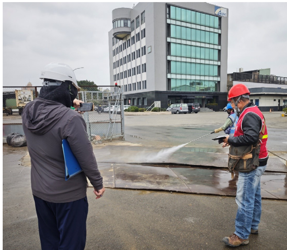
環保局核稽人員測試逸散性粒狀物管制措施（高壓沖洗設備）
